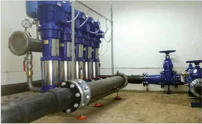
Zmodernizowana pompownia wody przy ul. Młynarskiej w Słupnie.
