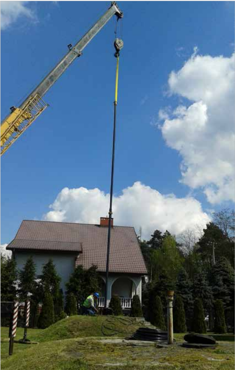
Czyszczenie mechaniczno – chemiczne na Stacji Uzdatniania Wody w Gulczewie
