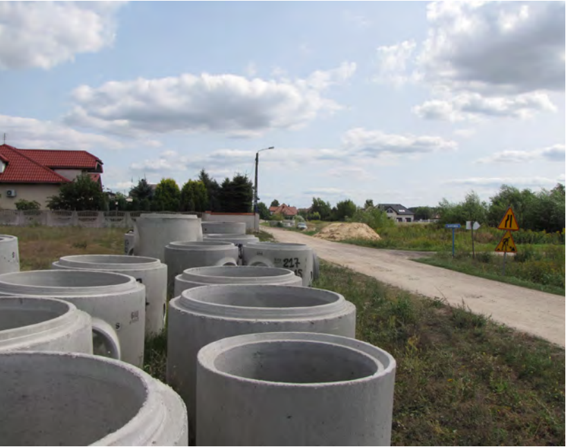
Ruszyła budowa kanalizacji deszczowej w ul. Bocianie w Słupnie
