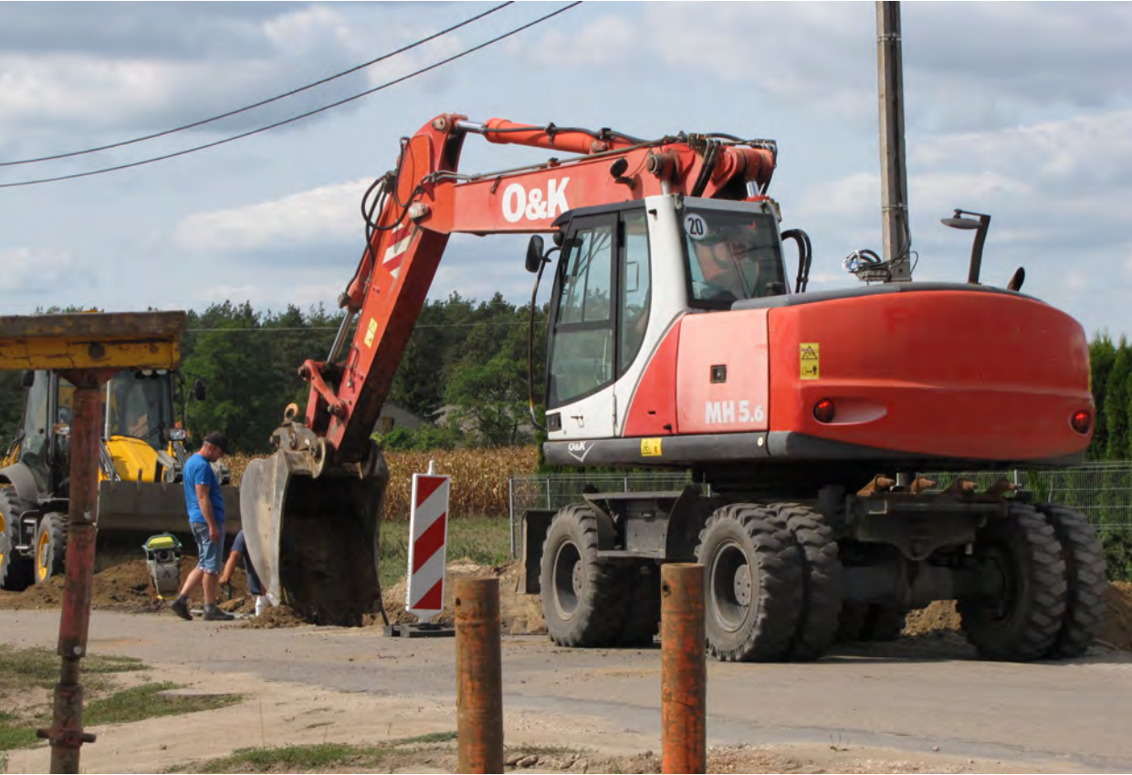
Trwa budowa ul. Jagiellońskiej w Liszynie
