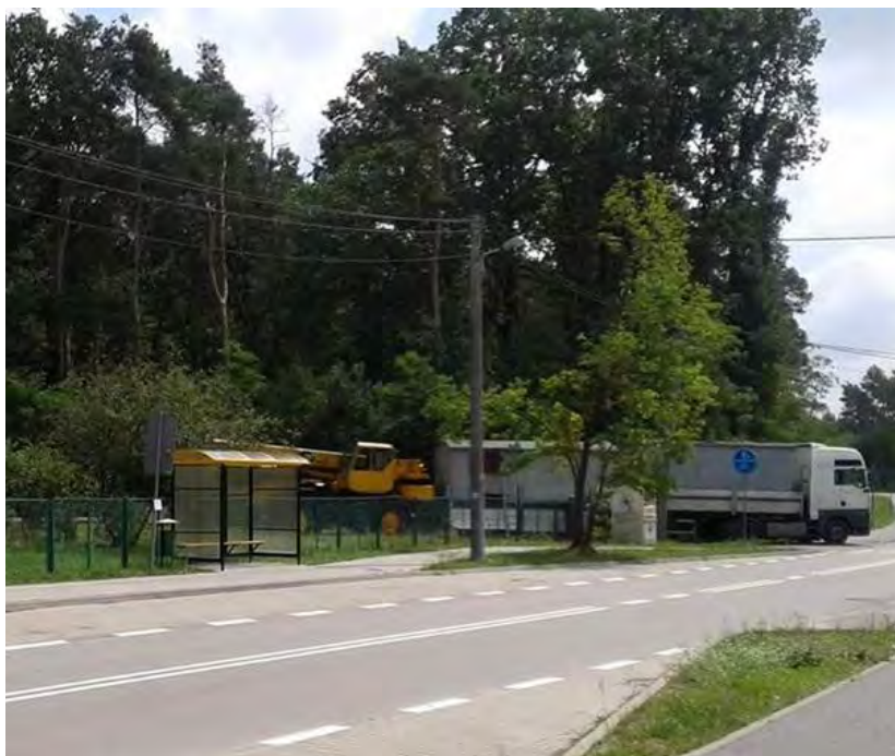
Liszyno- sala sportowa. Wykonawca przejął plac budowy
