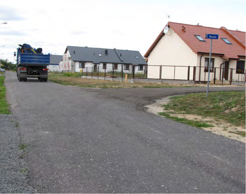
Świeżo położony destruktem w uliczkach na górnym Słupnie
