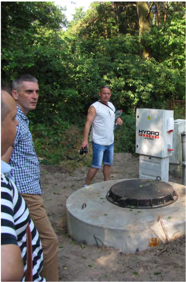
Nowa przepompownia ścieków na dolnym Słupnie
