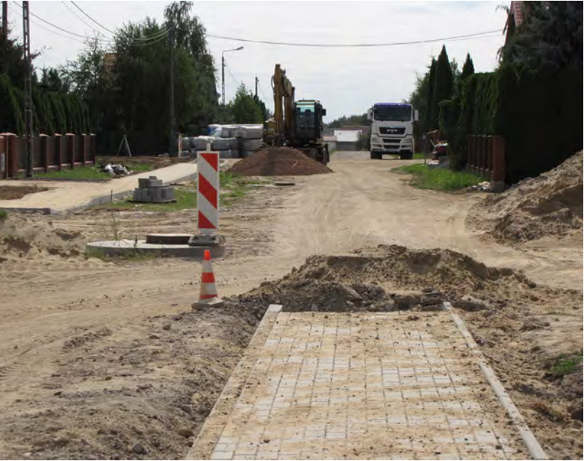
Budowa ul. Podbipięty w Nowym Gulczewie
