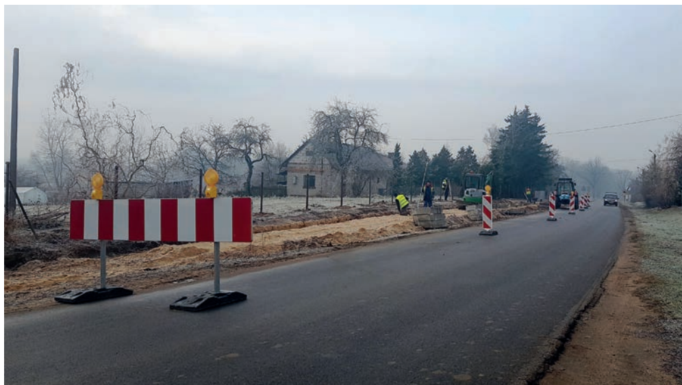
Budowa ścieżki pieszo - rowerowej Miszewko Str. – Świecieniec
