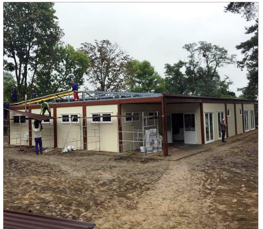
Budowa nowego żłobka w Słupnie
