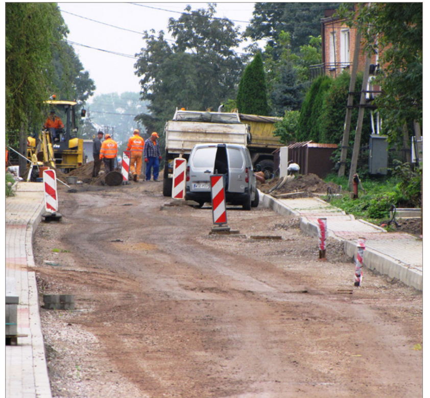
Budowa drogi Mirosław – Stare Gulczewo
