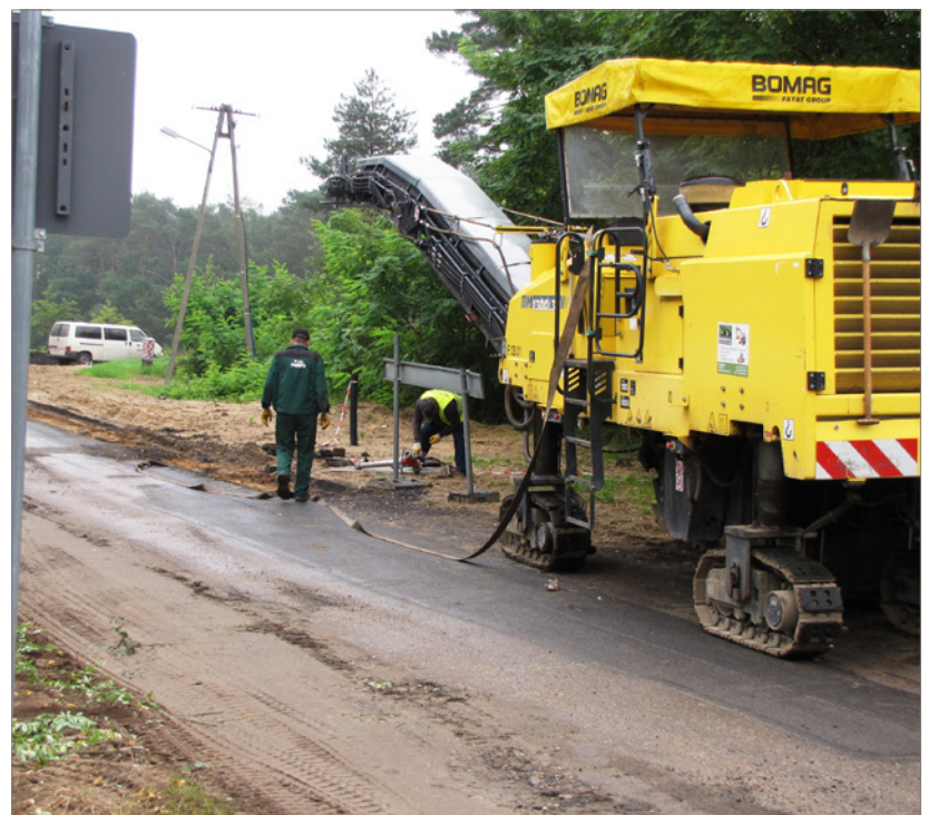
Budowa ulicy Pocztowej (droga Słupno- Liszyno)
