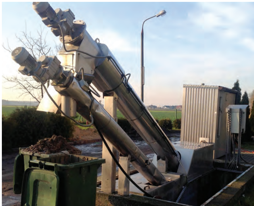
Oczyszczalnia ścieków w Słupnie
