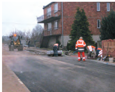
Budowa Drogi Mirosław - Stare Gulczewo
