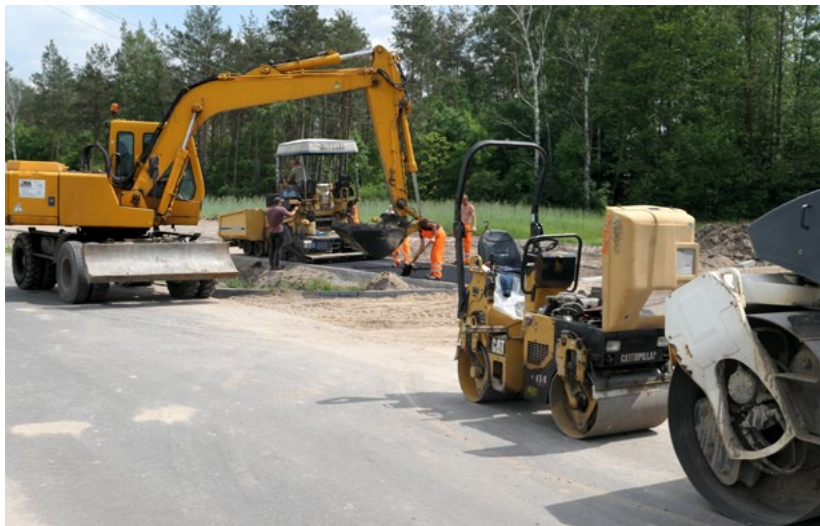
Budowa drogi Słupno - Liszyno
