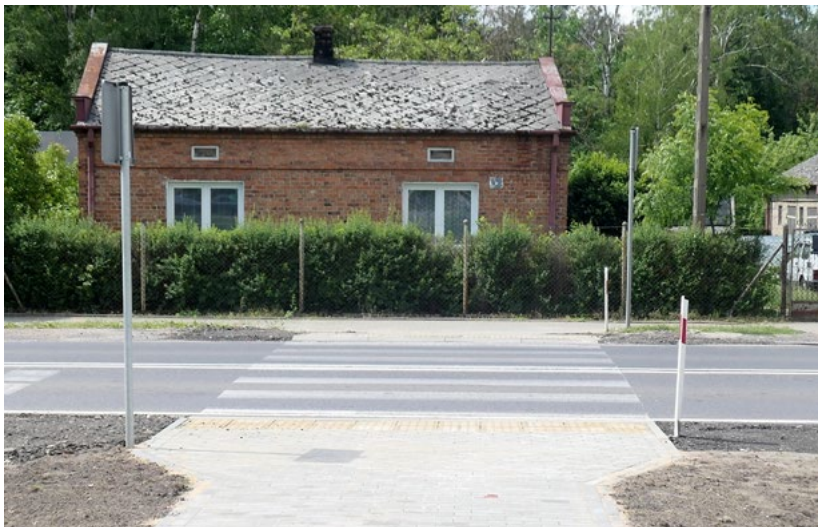
Nowy chodnik i przejście dla pieszych przy ul. Warszawskiej
