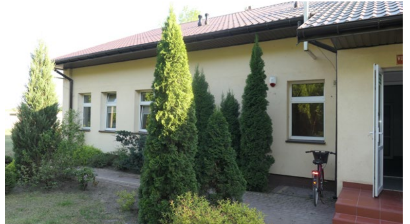
Odnowiona świetlica w Wykowie
