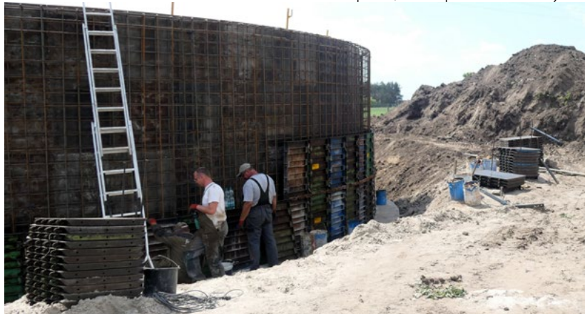
Modernizowana oczyszczalnia ścieków
