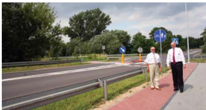
Ówczesny Starosta Płocki Piotr Zgorzelski z Wójtem Gminy Słupno Stefanem Jakubowskim na przebudowanym odcinku drogi krajowej 62 do osiedla Krzelewo
