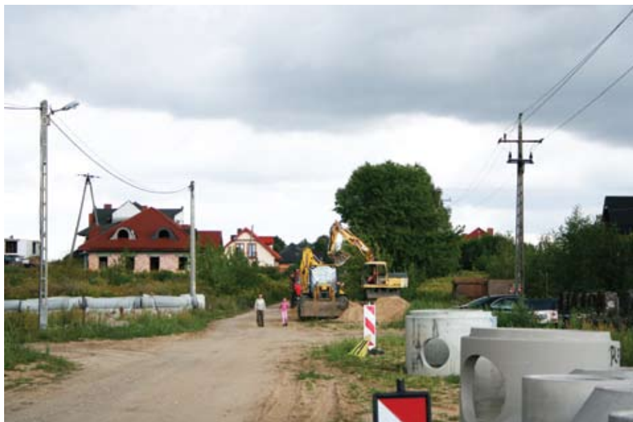
Prace budowlane na ul. Wiejskiej w Cekanowie
