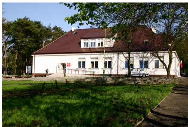
WYREMONTOWANY BUDYNEK STAREJ SZKOŁY W SŁUPNIE
