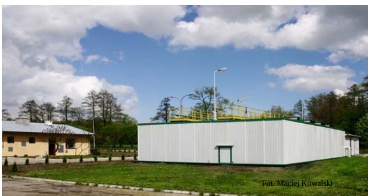
OCZYSZCZALNIA ŚCIEKÓW W SŁUPNIE
