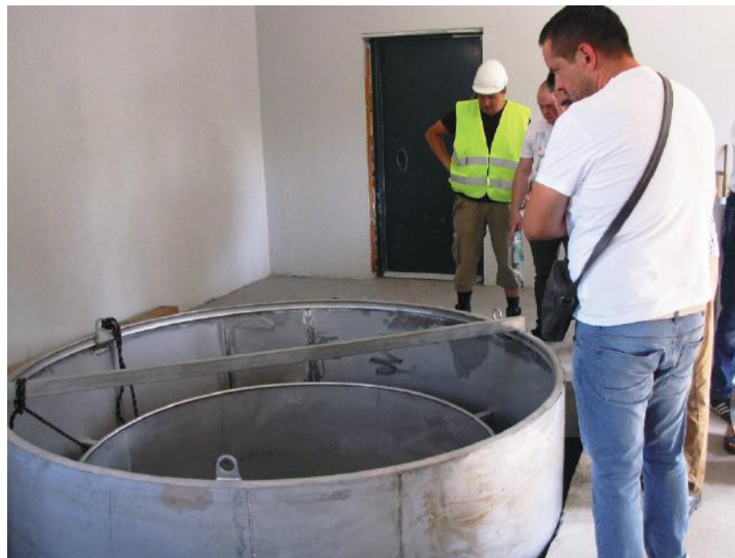
Modernizacja oczyszczalni ścieków.
