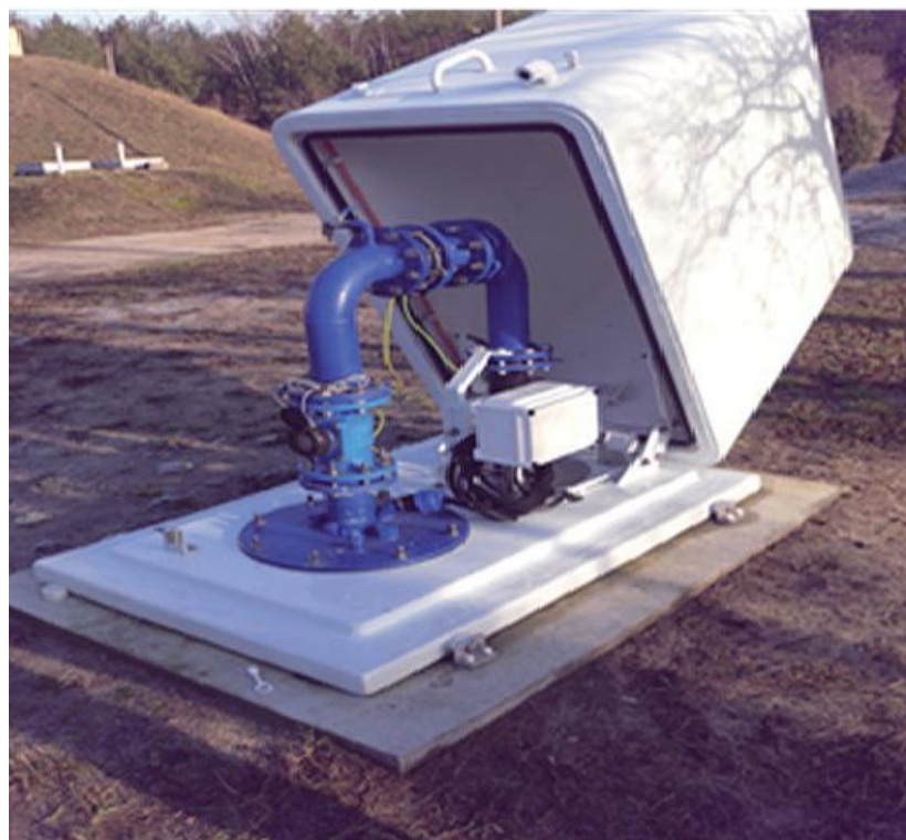
Nowa studnia głębinowa na SUW Bielino.
