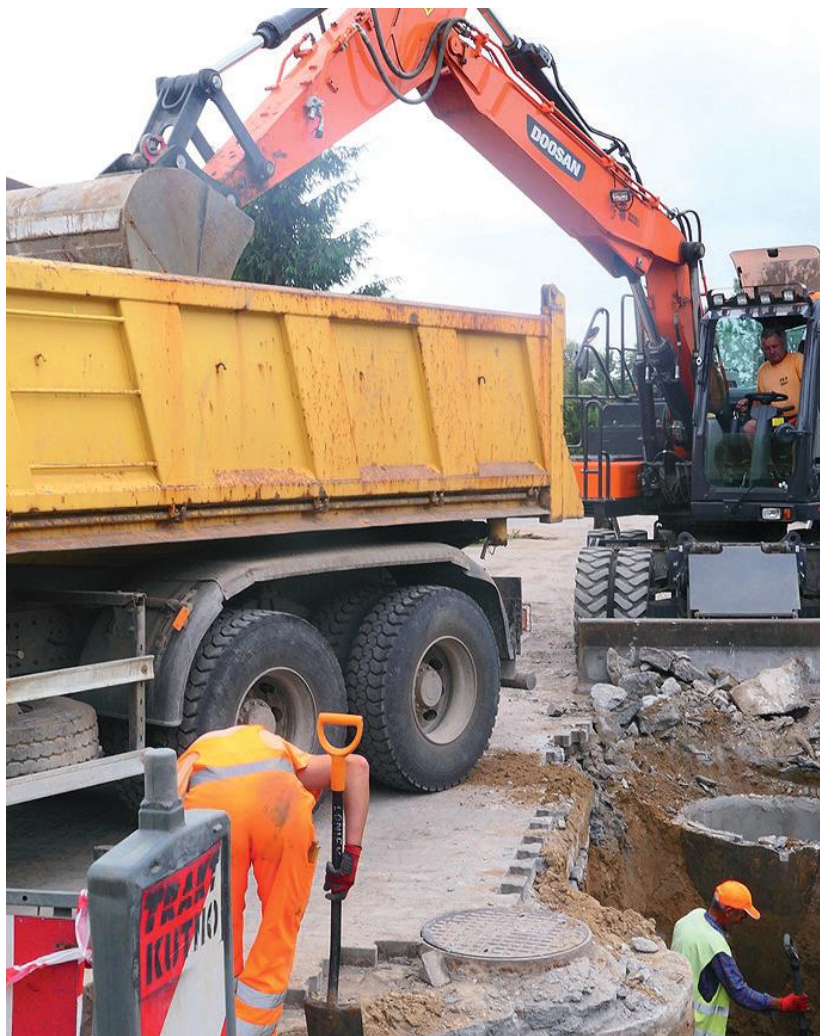
Nowe Gulczewo. Budowa ul. Czarnieckiego.
