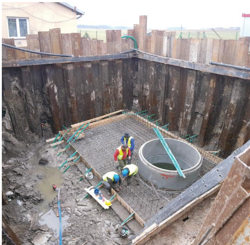
Budynek z systemem mechanicznego oczyszczania ścieków - w trakcie realizacji.
