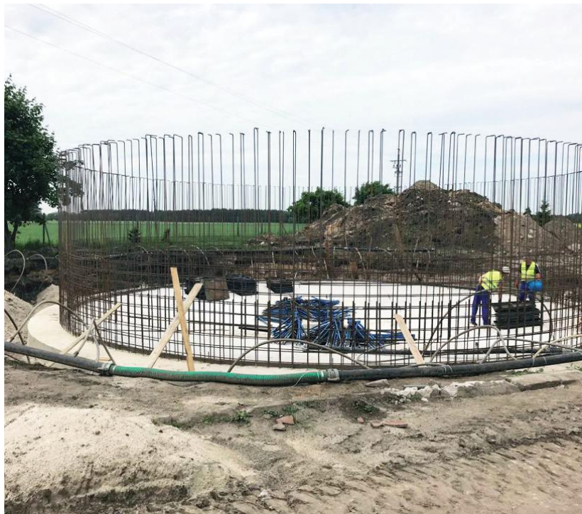
Modernizacja oczyszczalni ścieków w Słupnie.
