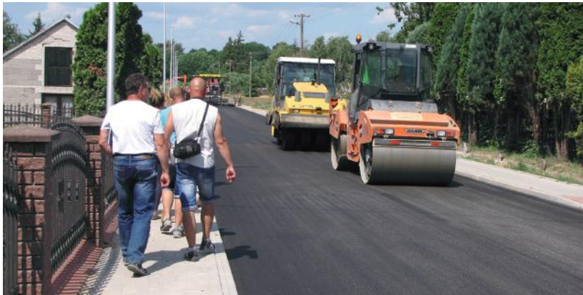
W Mirosławiu kładziony jest asfalt
