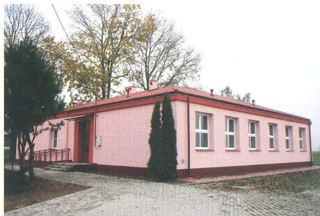
Świetlica po remoncie
