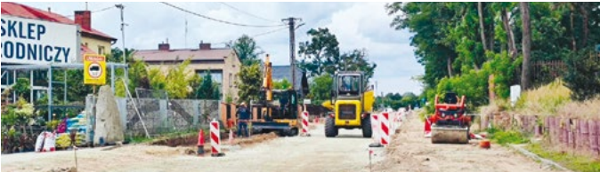
Budowa ul. Zagłoby w Nowym Gulczewie
